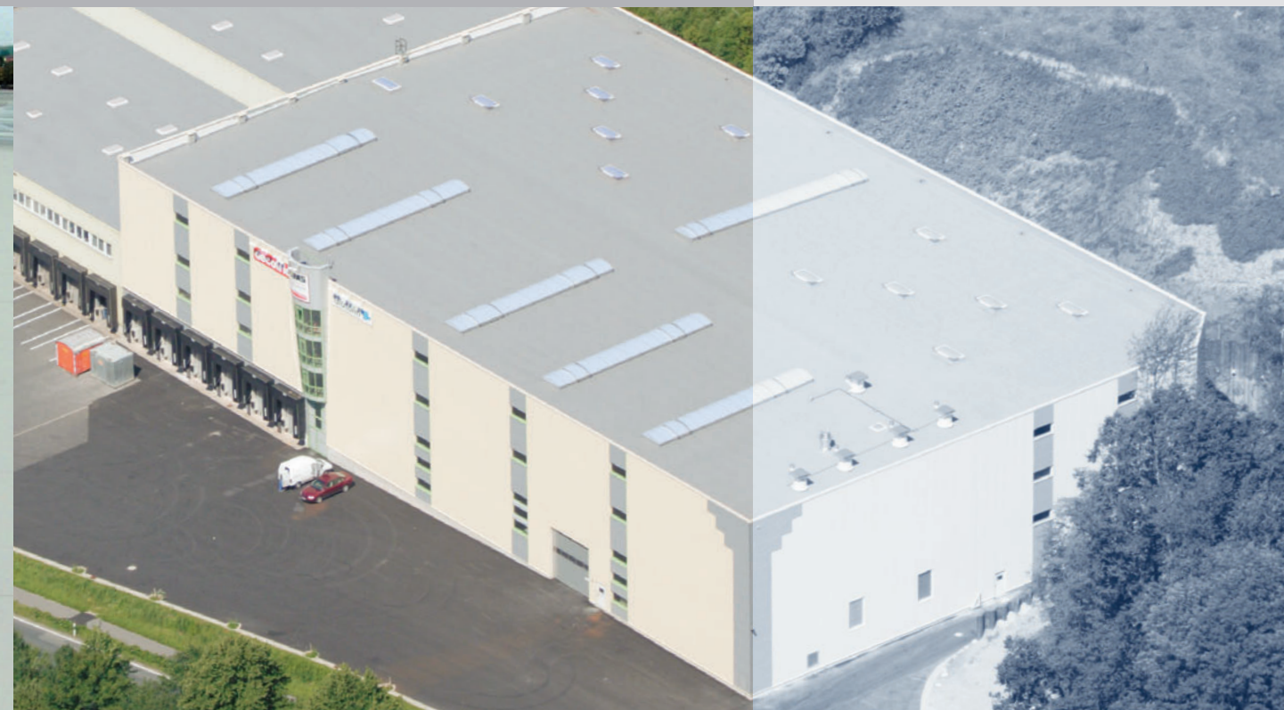
Pufas, Hann. Münden ExtruPol Dachabdichtung, 7.100 m 2
