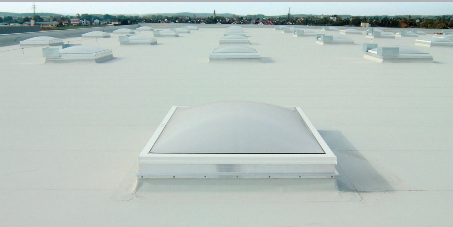
Lekkerland, Höchststadt ExtruPol Dachabdichtung, 11.000 m 2
