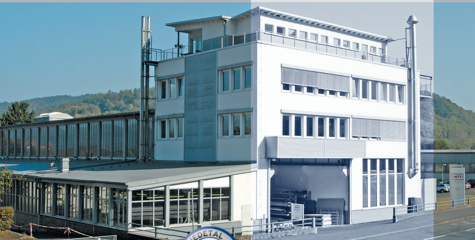
HTT, Hann. Münden ExtruPol Dachabdichtung, 4.000 m 2
